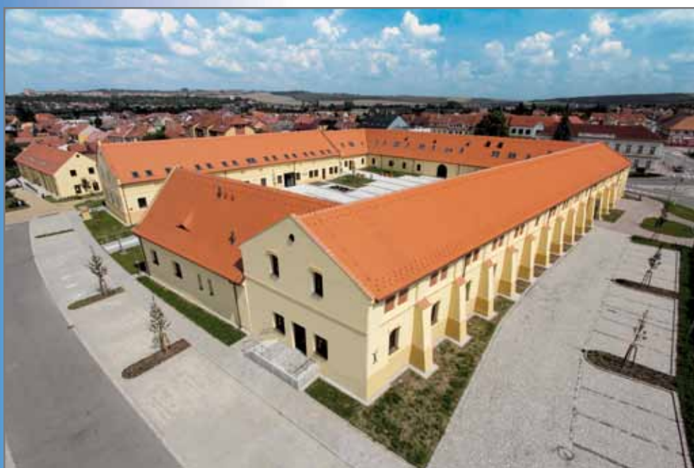
Panský dvůr po rekonstrukci
